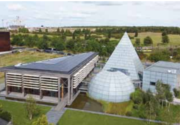
Abb. 3: 20 Jahre nach der Expo 2000 in Hannover präsentiert sich der Dänische Pavillon als innovatives Plusenergiegebäude. Das Architektur- und TGA-Planungsbüro Carsten Grobe Passivhaus verwandelte den fast 2.000 m 2 großen Gebäudekomplex in ein ökologisches Vorzeigeprojekt.
