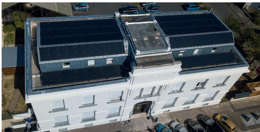
**EINHEITLICHE OPTIK DER SOLAR-FLÄCHEN:** Die 40 PVT-Kollektoren sind von den 66 PV-Modulen auf dem Dach nicht zu unterscheiden.
